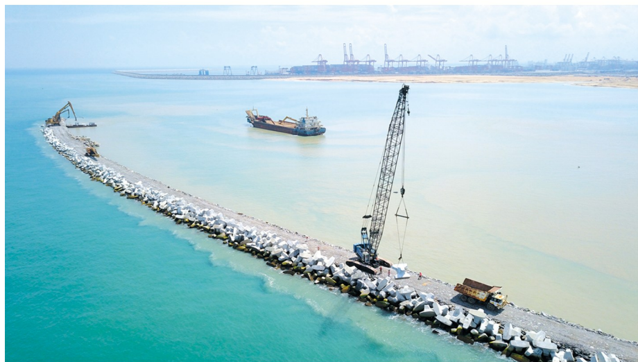
2018年4月18日,吊机在斯里兰卡科伦坡港口城项目的防波堤上作业。
